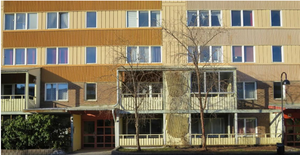
Byggnaderna har en-, två- och trelufts-fönster
