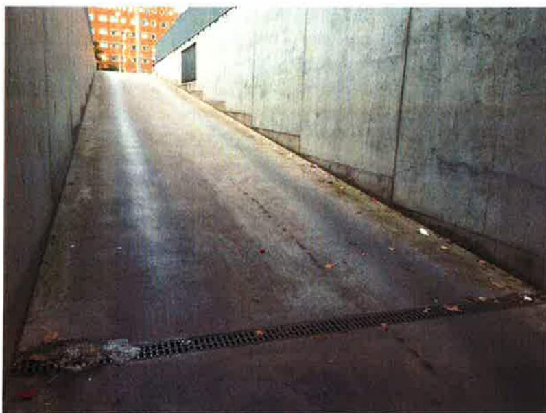
Figur 10. Exempel på dagvattenränna vid garageinfart.
