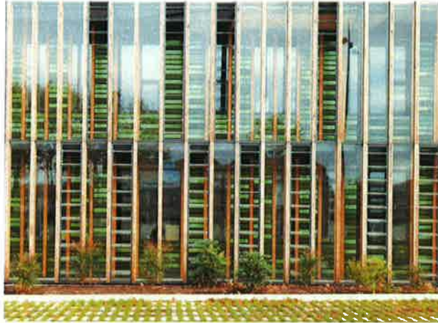
Kulören på fasaden bakom skymtar igenom det yttre fasadlivet som blir ett stort växthus.
