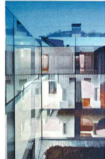
spegelglas som både genomskiktig och reflekterande fasad på en och samma gång
