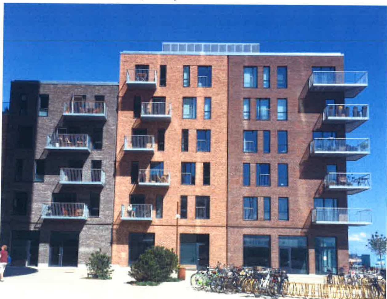
Referensbild: skarvar som medveten gestaltning samt balkonger.
