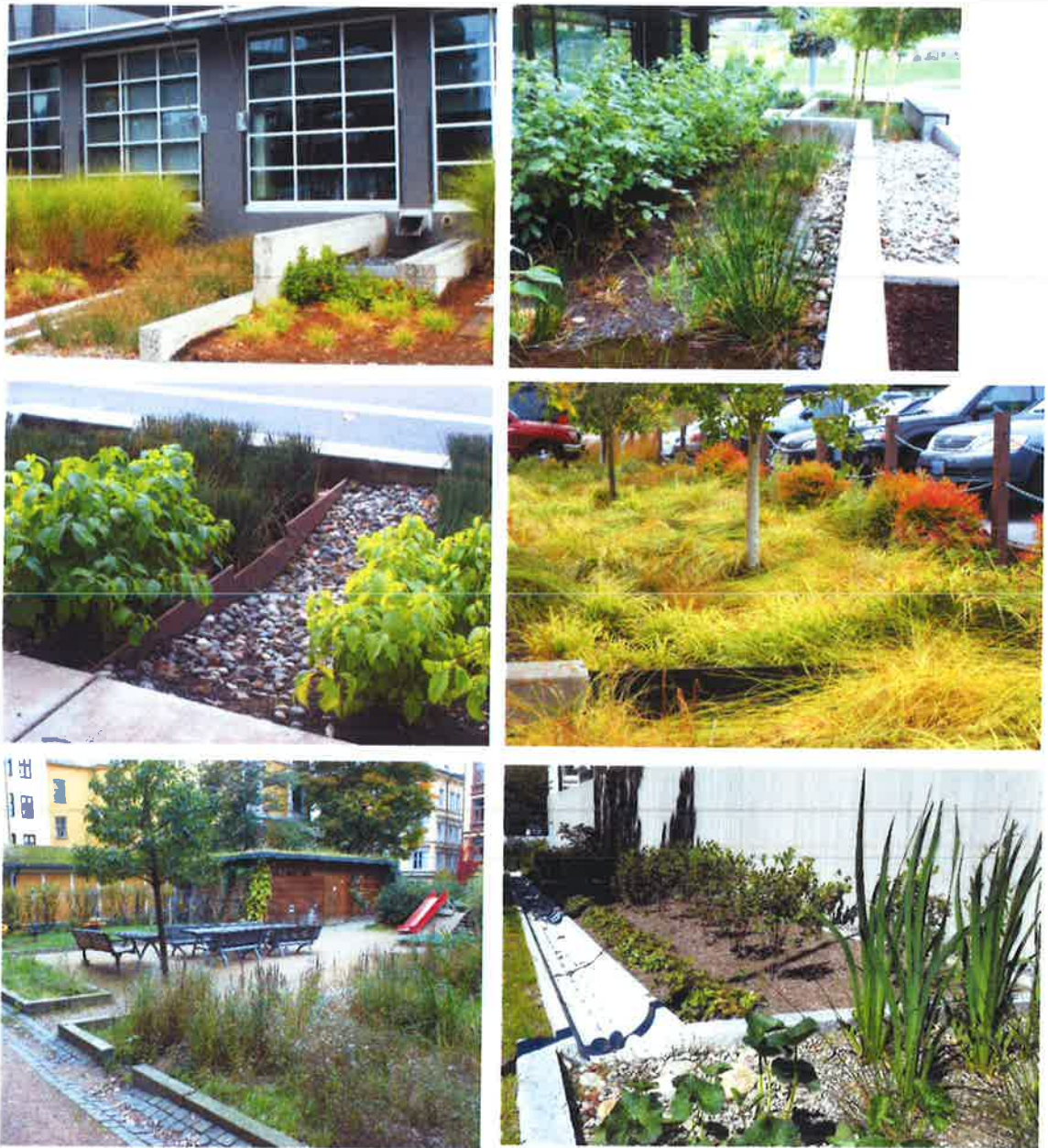
Figur 6. Bilderna visar exempel på seriekopplade regnbäddar på kvartersmark samt exempel på överfall och dämmen. Rännor kan avleda dagvattnet till regnbäddar men även fungera som bräddning i ett seriekopplat system. Exemplen kommer från Portland, Oslo och Stockholm.
