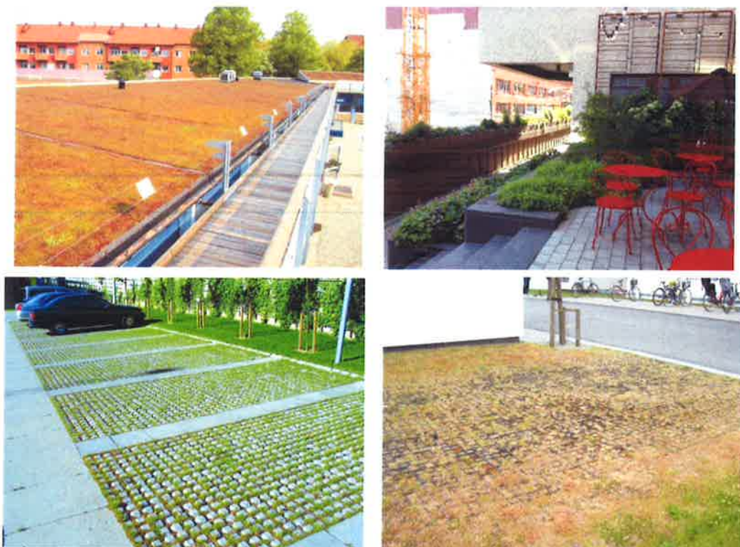
Figur 4. Nedre bilderna visar exempel på genomsläppliga beläggningar för parkeringsplatser och den övre bilden visar en bit av ett grönt tak i Stockholm som även används som en takträdgård.
