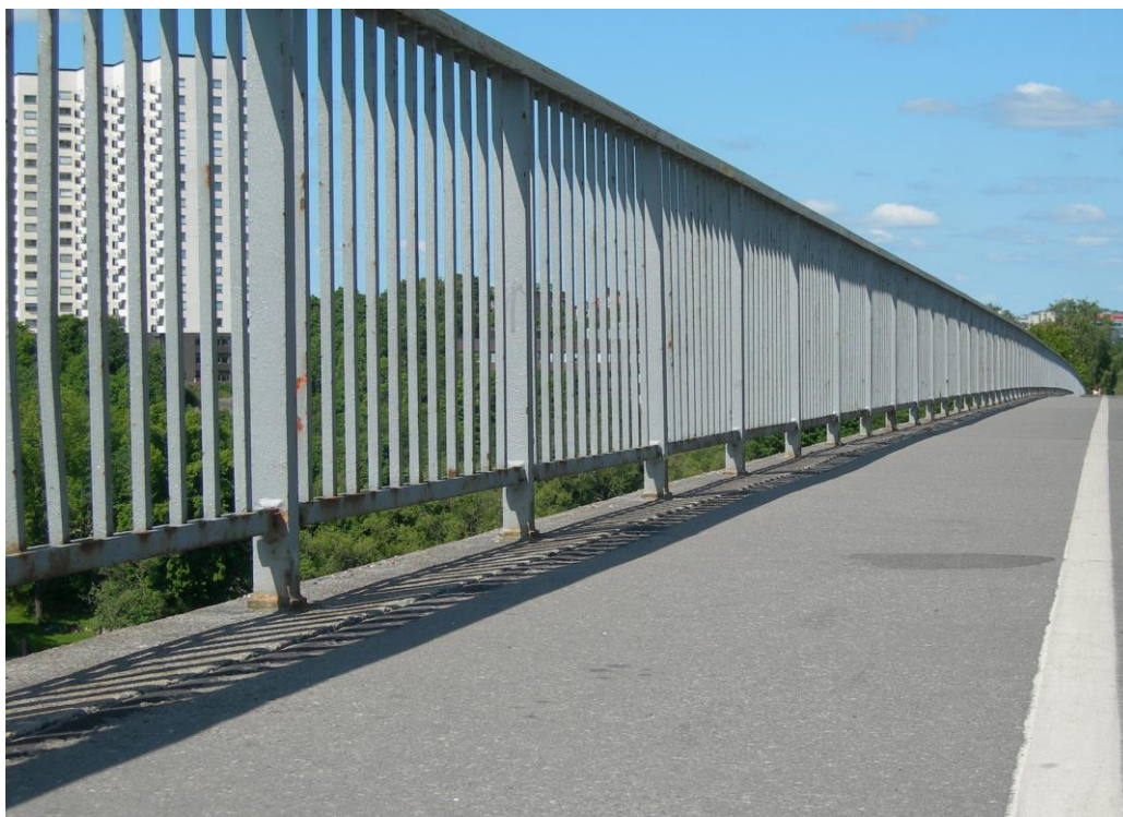
Foto 1. Kantbalk med räcke. Överytan skyddas inte mot fukt och vägsalt av ett tätskikt. De flesta kantbalkar ligger högre än vägbeläggningen. Om de inte gör det så brukar man åtgärda detta då en bro renoveras.
