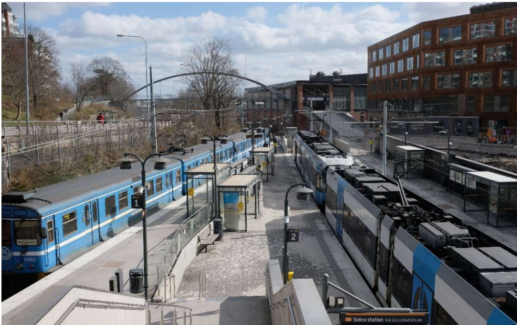
Foto över spår område och perronger. Saltsjöbanan till vänster i bilden och Tvärbanan till höger. Karlqvist, 2020.
