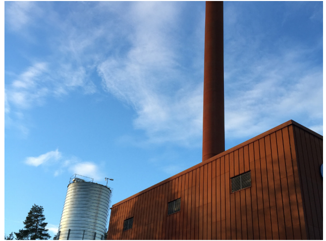
Befintlig panncentral i Orminge.
