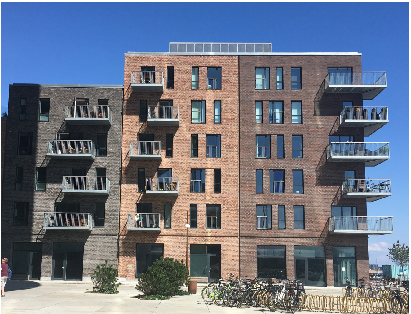
Balkonger och fasad.
