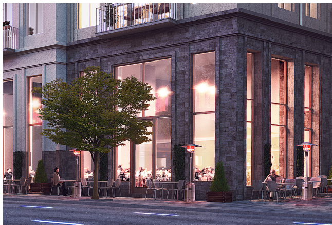
Tydligt markerad sockelvåning (Källa: DinellJohansson).
