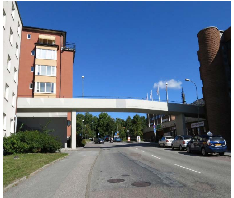
3-Bro över GC-väg på Flädervägen 1, Älta. IdNr:k-113. Konstruktionslängd 6 m. Bredd 14,9.
