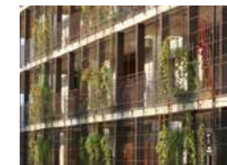
Referens entrébalkong med växtlighet / spaljé.
