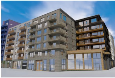
Vy från tunnelbanastations entré
