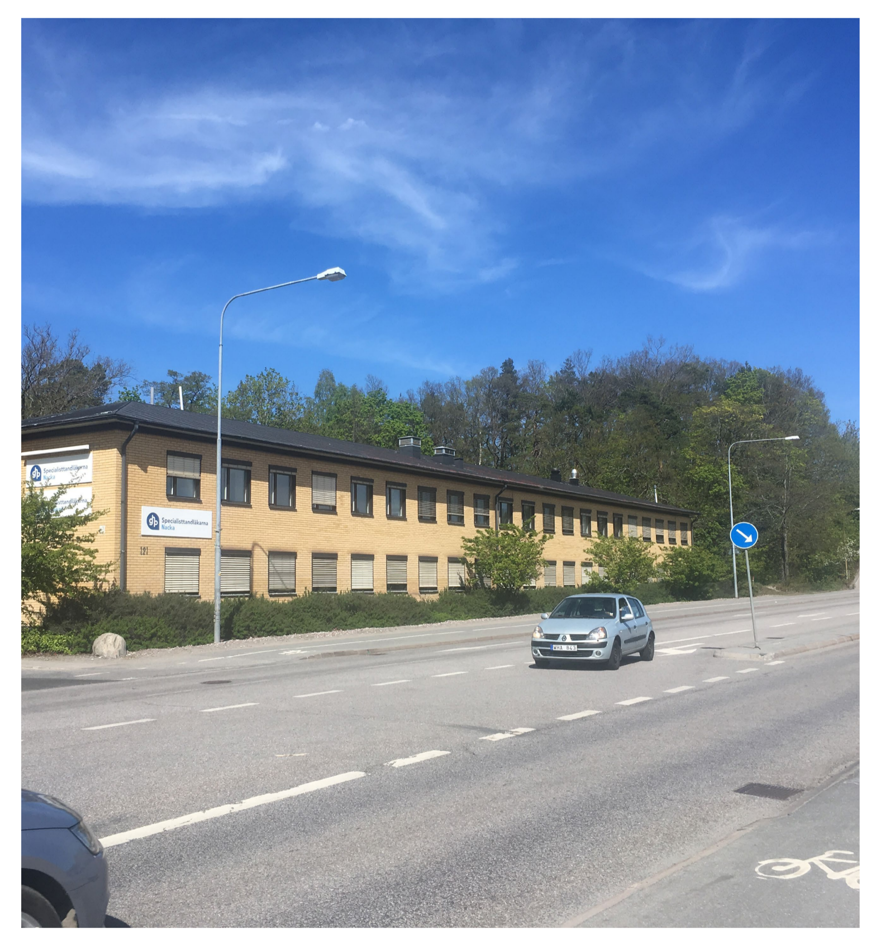
Kontorsbyggnad mot Värmdövägen
