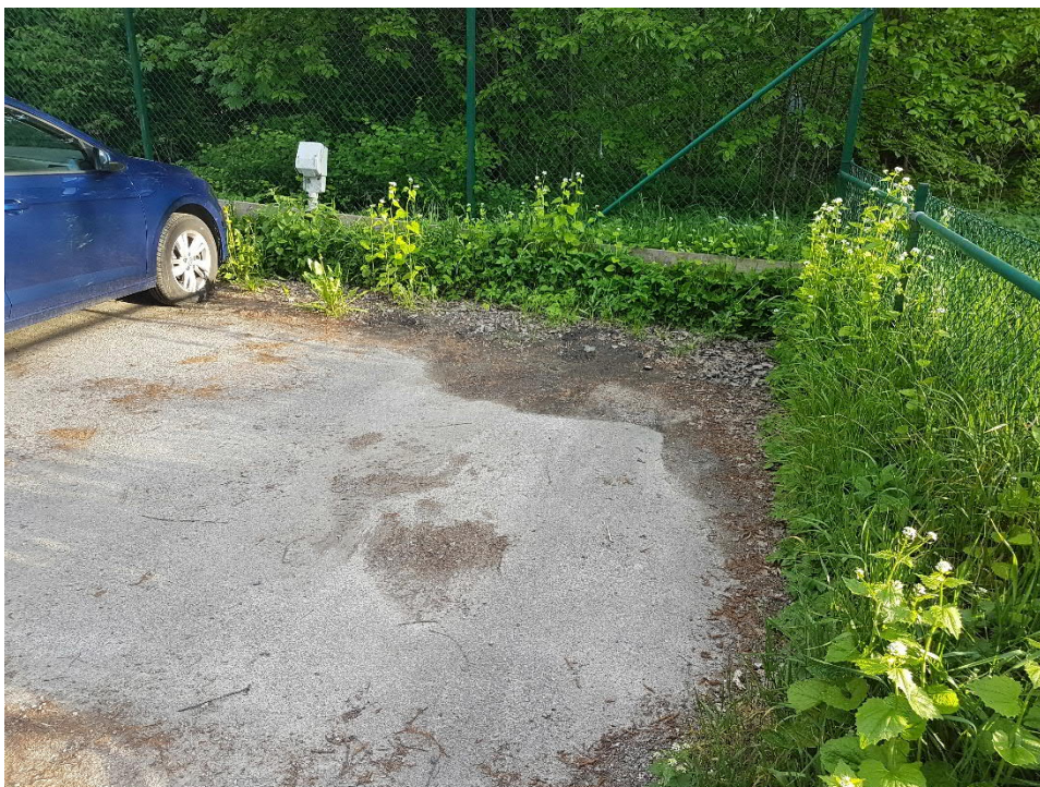
Foto 2. Befintlig parkering, Ugglevägen. Ackumulerat sediment tyder på att dagvatten rinner över parkeringen och vidare in i skogsområdet.
