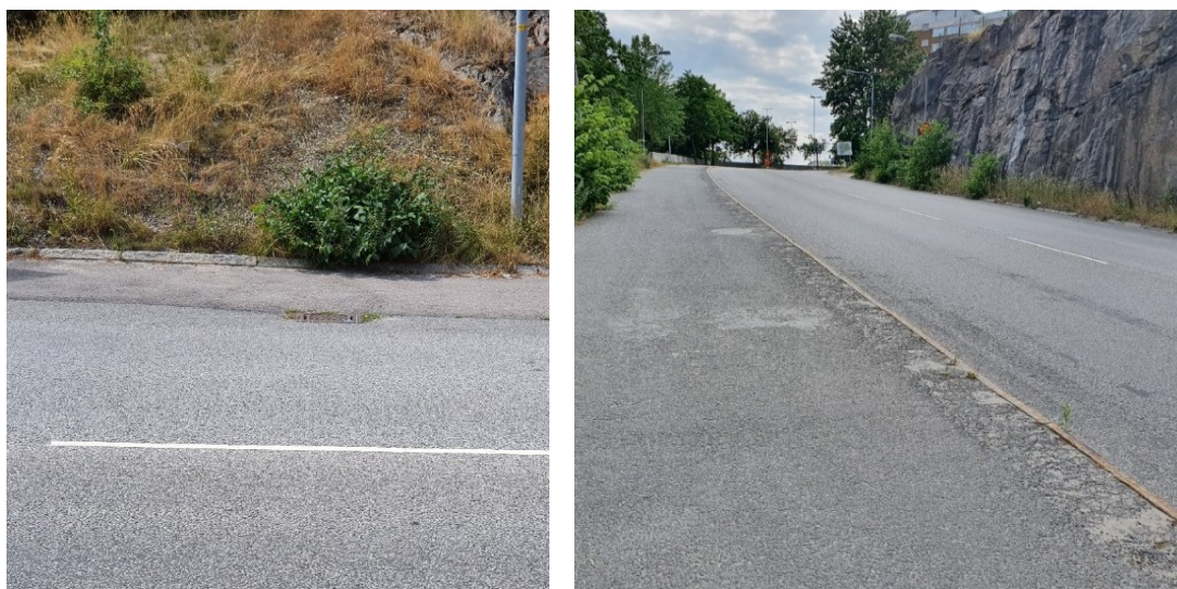
Figur 2-8. Planområdet lutar kraftigt. Dagvatten tas endast in i ledningsnätet med små brunnar i sidan av vägen. Foto från platsbesök 2021-07-16.
