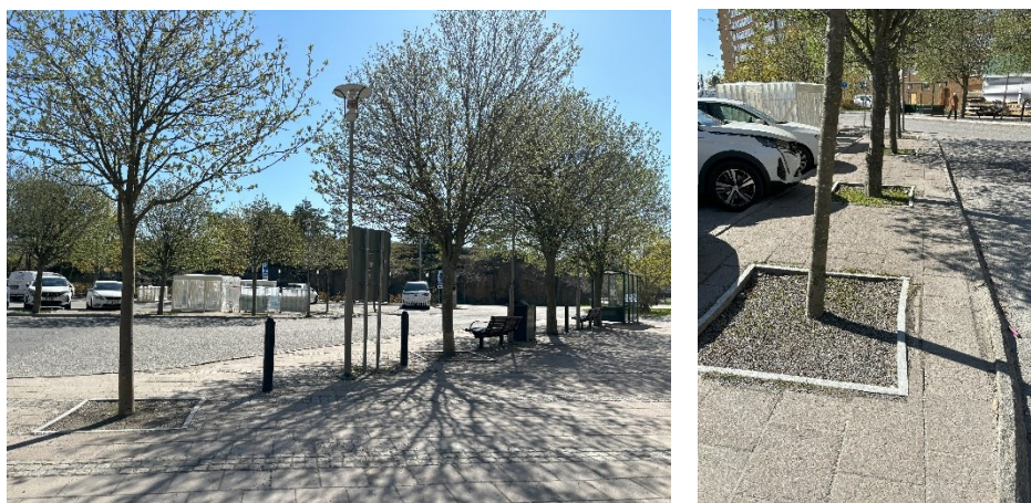
Figur 2-7. Skelettjord/trädgropar vid busstorget på Henriksdalsberget. Foton tagna på platsbesök 2024-05-07.
