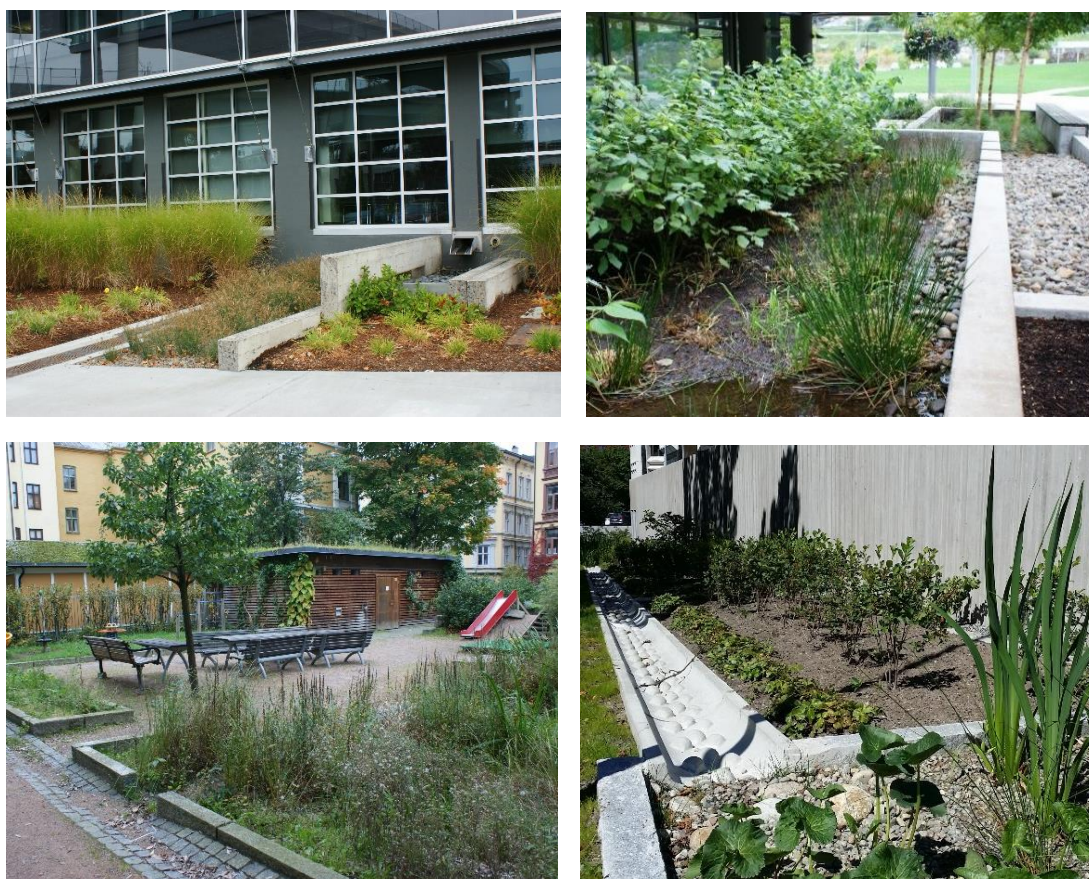
Figur 6. Bilderna visar exempel på seriekopplade regnbäddar på kvartersmark samt exempel på överfall och dämmen. Rännor kan avleda dagvatten till regnbäddar men även fungera som bräddning i ett seriekopplat system.
