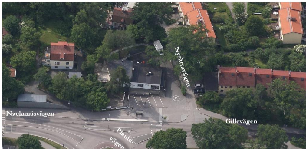
Figur 3, flygbild mot söder över den aktuella fastigheten innan projektet byggdes ut.
