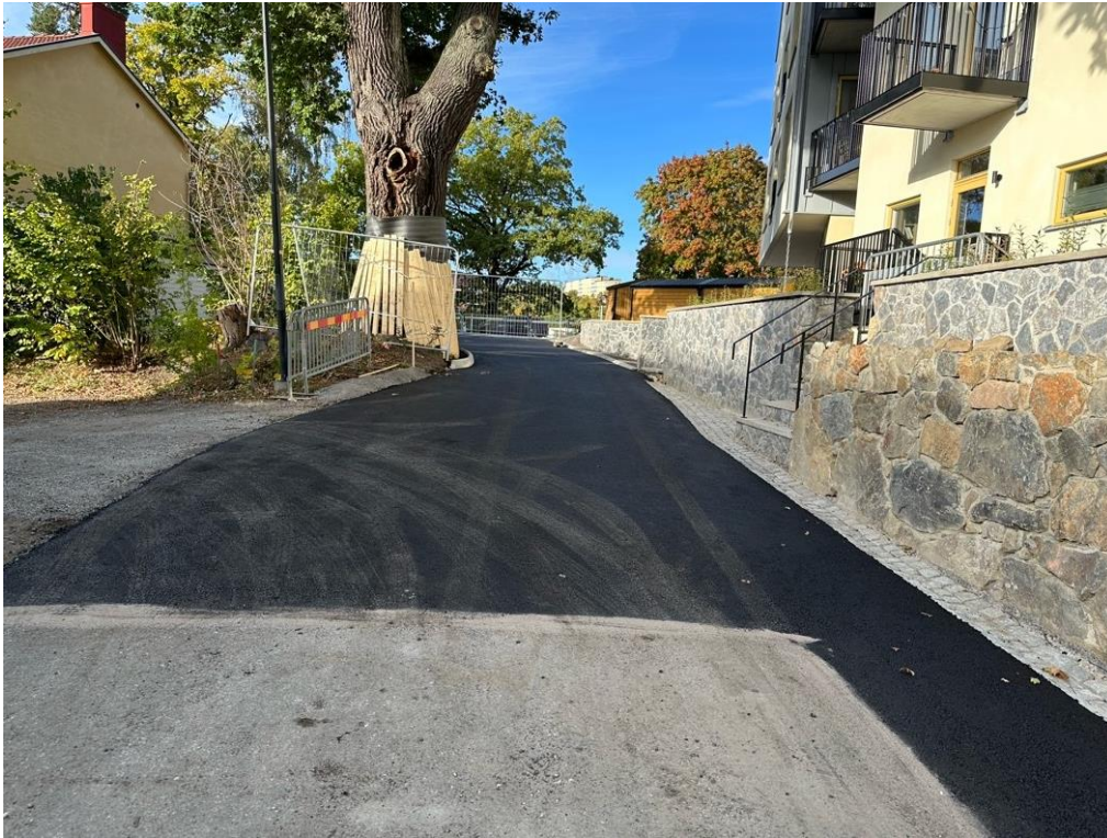
Figur 6, bild tagen efter godkänd besiktning av allmänna anläggningar
