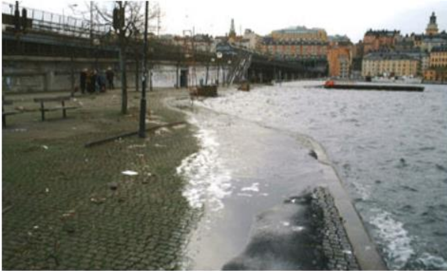
Översvämning från Mälaren vid Gamla stans tunnelbanestation. Foto: Länsstyrelsen Stockholm
