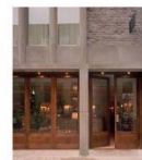
Entrémotiv med samspel av betong, tegel och trä
