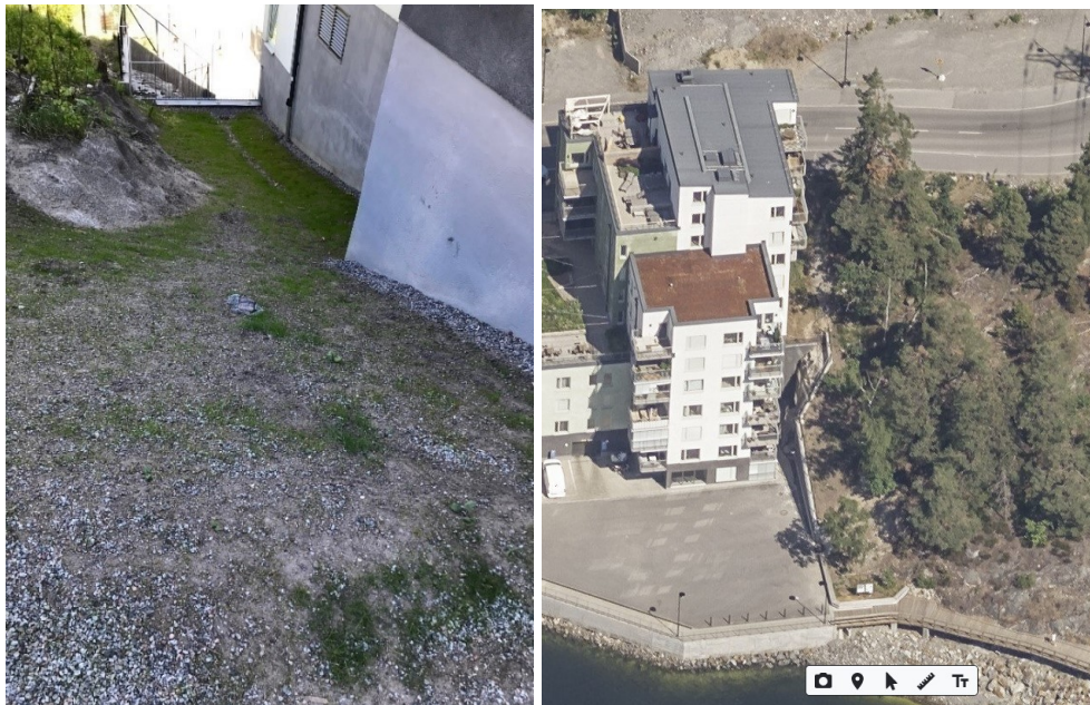
Figur 19 (vä): Mark för rinnstråk öster om byggnaden på Tollare 1:455. Sedd från Tollareslingan och mot söder. Foto: Nacka kommun. Figur 20: (hö): Den östliga byggnaden med närområde på Tollare 1:455, sett från söder. Källa: Mapspace.
