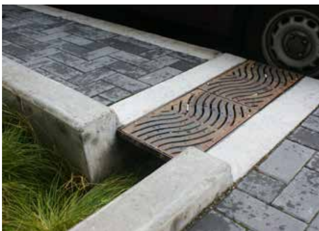
Referensbild, SWECO, dagvattenhantering, vattenränna
