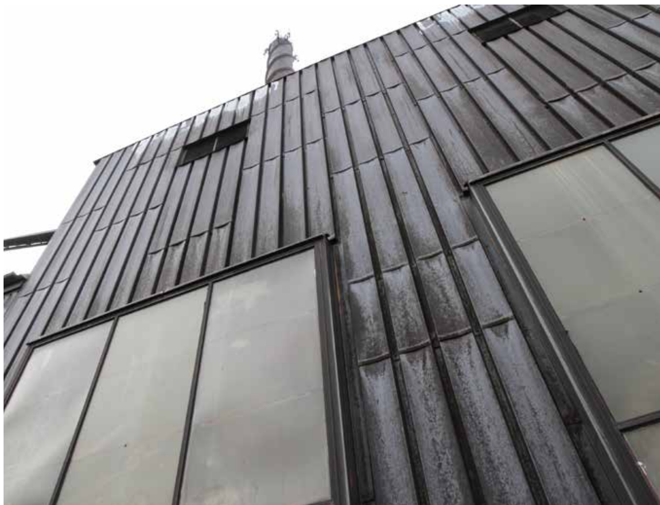
Panncentralen är centralt placerad och skorstenen syns på långt håll. Byggnaden har en robust karaktär med fasader och skorsten i cortenplåt.
