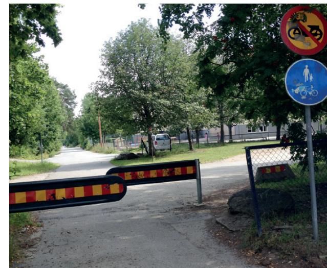
Hinder på gång- och cykelbana.
