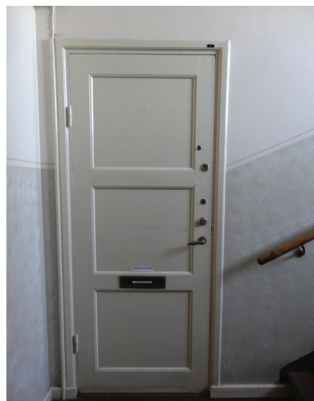
I det äldre lamellhuset hittas denna typ av spegeldörr med tre lika stora speglar som förekom omkring 1930. Dörrtypen finns även i radhusen och bör så långt det är möjligt bevaras. Funktionalismens helsläta dörrblad hade ännu inte kommit i bruk. Dörrfodren har slanka dimensioner. Om lägenhetsdörrar mot trapphus måste bytas ut bör man utgå från befintlig utformning.
