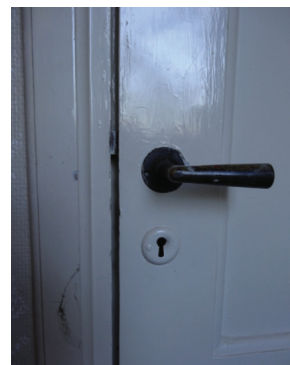
Dörrfoder, trycke och nyckelskylt av 1930-talstyp. Det nätta fodret har en liten profilering utmed ytterkanterna. I snickeridetaljerna har funktionalismen ännu inte blommat ut, vilket kan berätta om att huset befinner sig i ett arkitektoniskt brytningskede.
