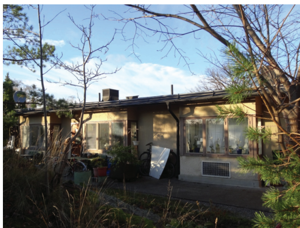
Butikshusets baksida med indragna uteplatser och burspråksliknande fönsterpartier för lägenheterna. Utformningen påminner om radhusens söderfasader med indragna uteplatser. Delar av denna fasad ska kopplas ihop med en ny byggnadsvolym inrymmande förskola. Det är då viktigt att återstående delar behåller sin karaktär.
