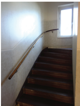
Trapphus i det äldre lamellhuset med svängda hörn. Även handledaren följer hörnets form. Till höger detalj av handledaren med mjuk avslutning och elegant väggfäste med profilerad plåtrossett.
