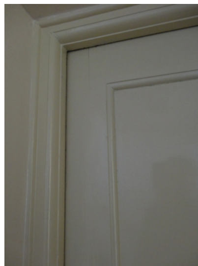
Mjukt formade profiler på dörrkarm och dörrspegel.
