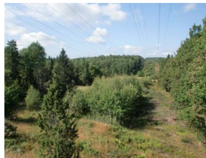
Befintlig kraftledning i västra Kil
