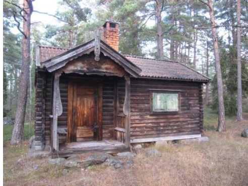
Lekstugan som ligger på höjden öster om huvudbyggnaden. (Byggnad nummer 14)
