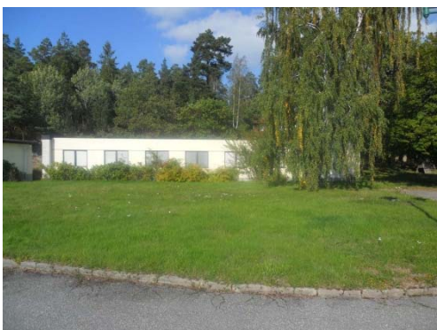
Förlägningsbyggnaden norr om gästhemmet. (Byggnad nummer 10)
