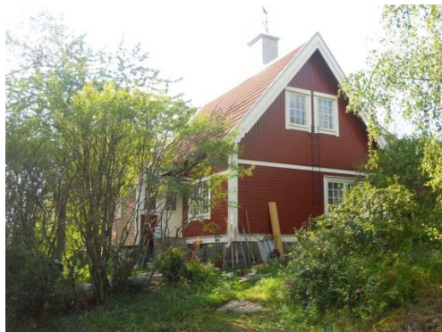
Vaktmästarbostaden strax norr om huvudbyggnaden. (Byggnad nummer 7)
