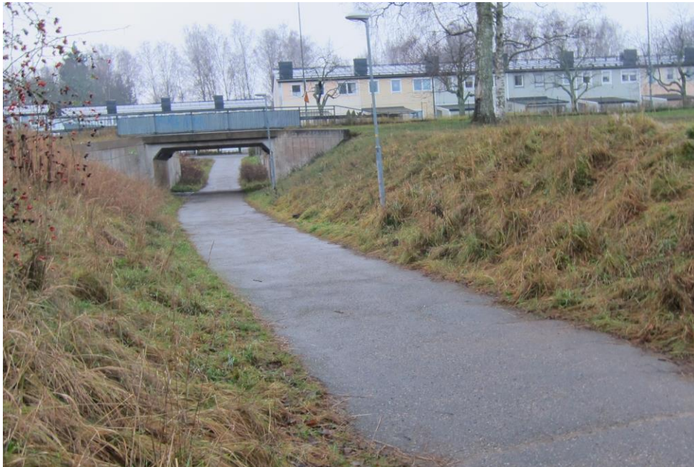
Figur 5 Tunnel för gång- och cykeltrafik under Evalundsvägen
