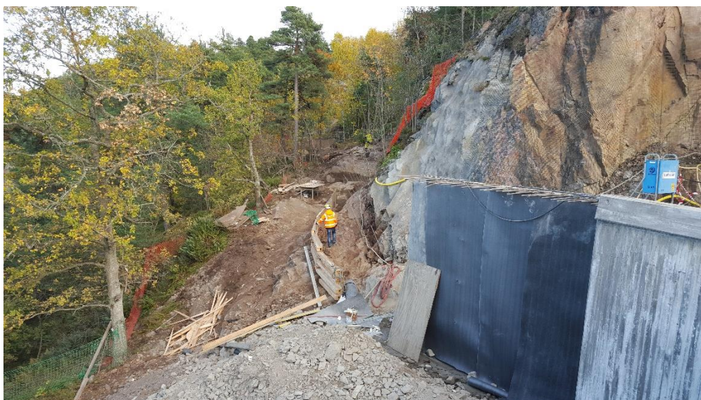
Bild 5. Vy från bron mot GC-vägen till Vikdalsvägen med formsättningen för stödmurarna mitt i bilden.
