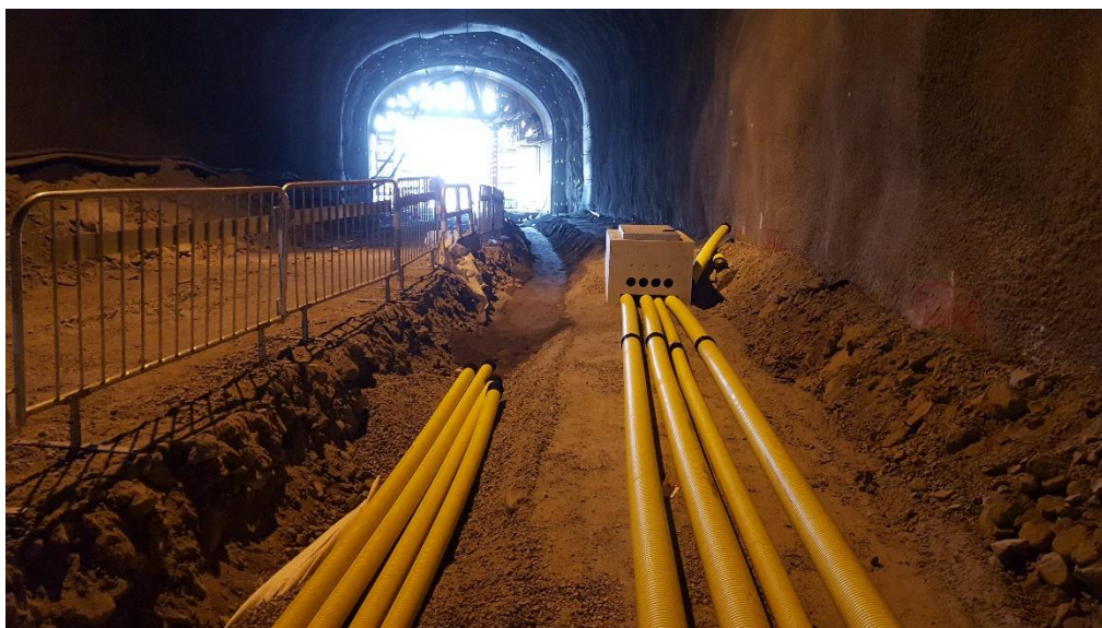
Bild 7. Markarbeten för elkanalisation i tunneln
