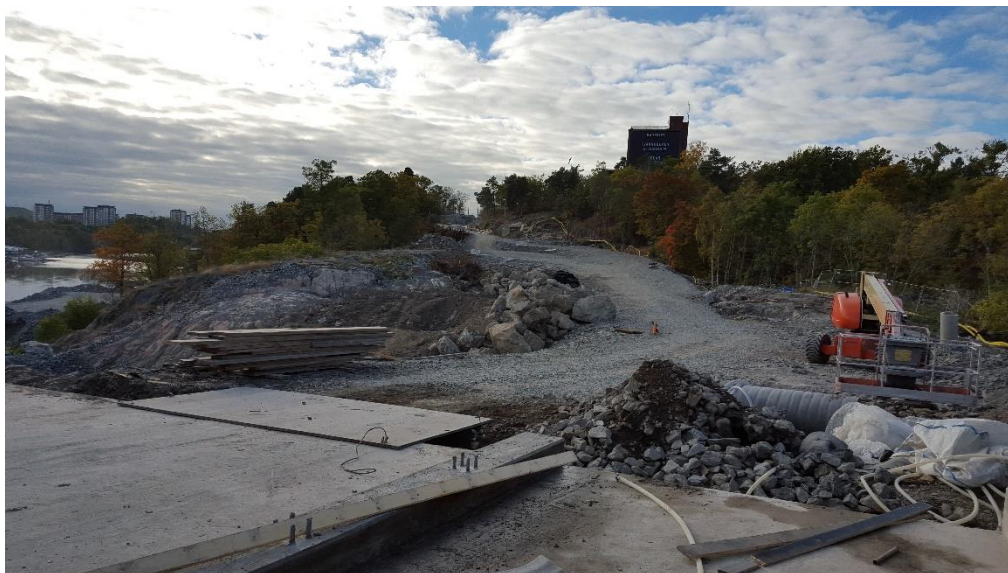
Bild 1. Monteringsytan som är övertagen av KUAB.
