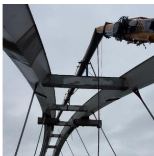
Bild 12. Den böjda lyftbommen på mobilkranen.
