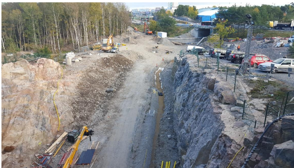
Bild 9. Kanalisering för el på västra sidan och iordningsställande av slänt på östra sidan efter rörläggning för VA.
