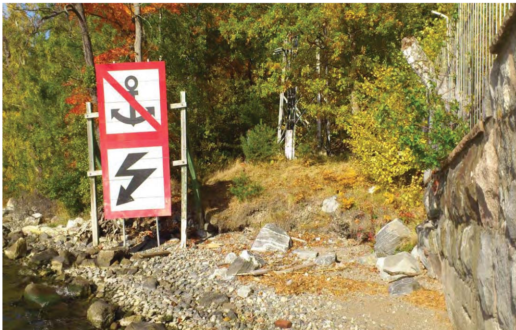
Figur 26. Landtagningsplatsen på Lidingösidan. Kabelstolpen, till höger om ankringsförbudsskylten, står nära strandlinjen.
