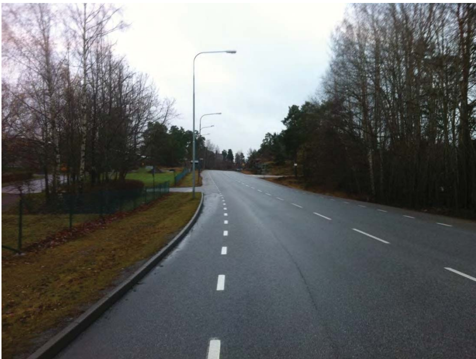
Figur 16. Norra delen av Ormingeringen. Vy söderut. Kabelpaketet planeras gå till vänster i bild.
