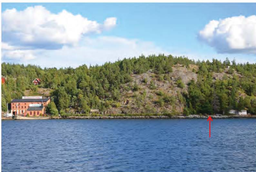
Figur 24. Sjøkablarna går ut från Nackasidan efter borrhning genom Telegrafberget, se pilen.
