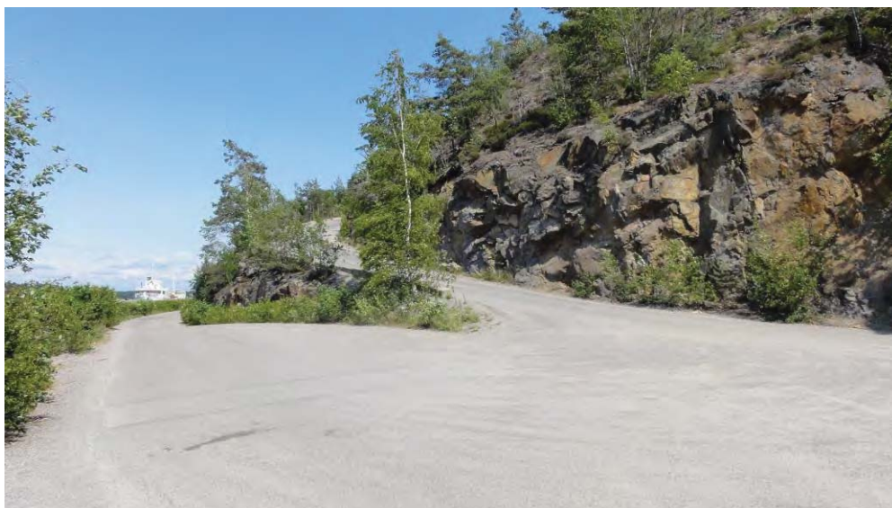
Figur 22. Telegrafberget, Skarpövägen. De borrhade kablarna kommer ut vid denna vändplats där skarvning mellan mark- och sjökablar kommer ske.
