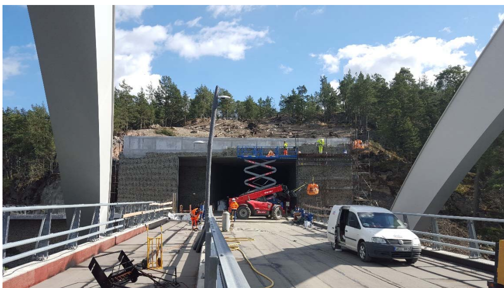
Bild 5. Gabionmurar på norra tunnelmynningen.
