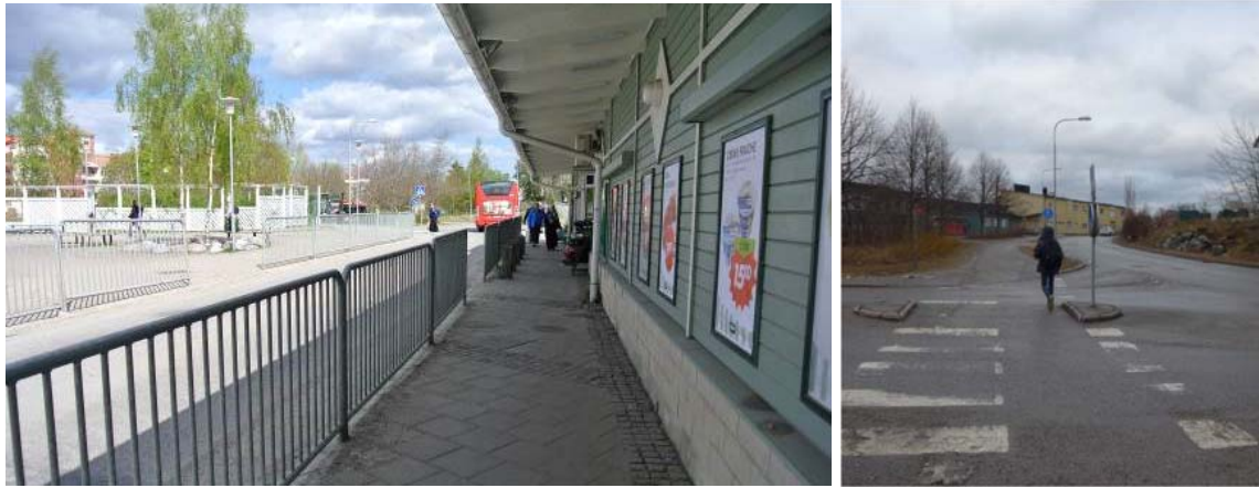
Fotot till vänster: Bussgatan vid Jarlabergsvägen, staket samt vändplatsen för buss. Foto: Sweco och Liljewall
