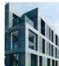
Synlig betongstomme som grafiskt mönster Zentrumsüberbauung Rosengarten / Max Dudler
