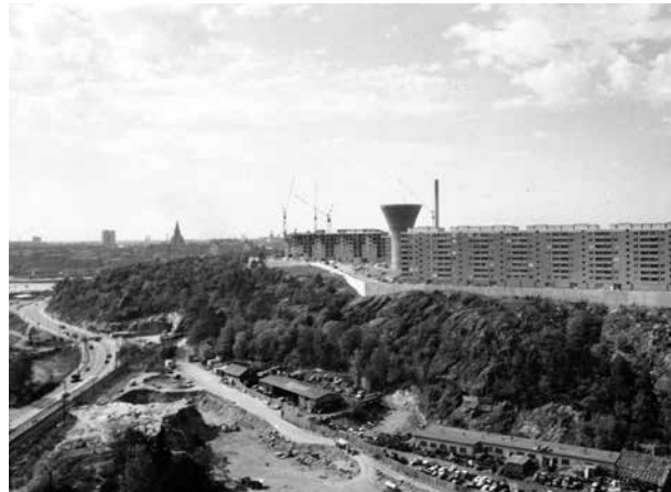
Bebyggelsen på Henriksdalsberget närmar sig sin fullbordan. Nedan i bild har arbetarna börjat med Värmdöleden.
