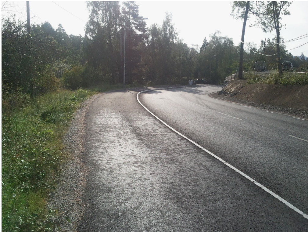
Kummelnäsvägen efter ombyggnad, med ny gångbana
