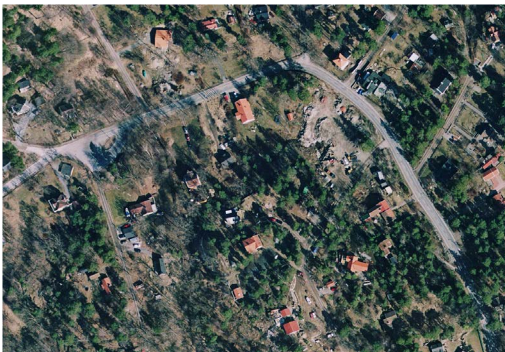
Del av Kummelnäsvägen före ombyggnad
