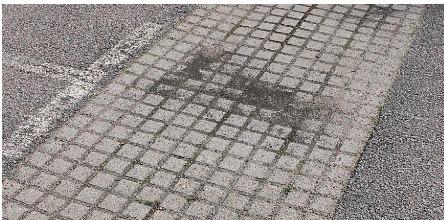
Figur 18 Genomsläpplig beläggning i form av stenplattor med avstånd mellan plattorna. Bilden visar på hur hålrummen kan sättas igen med partiklar (Sweco).
