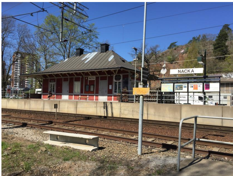
Figur 22. Stationsbyggnad vid Nacka station.
