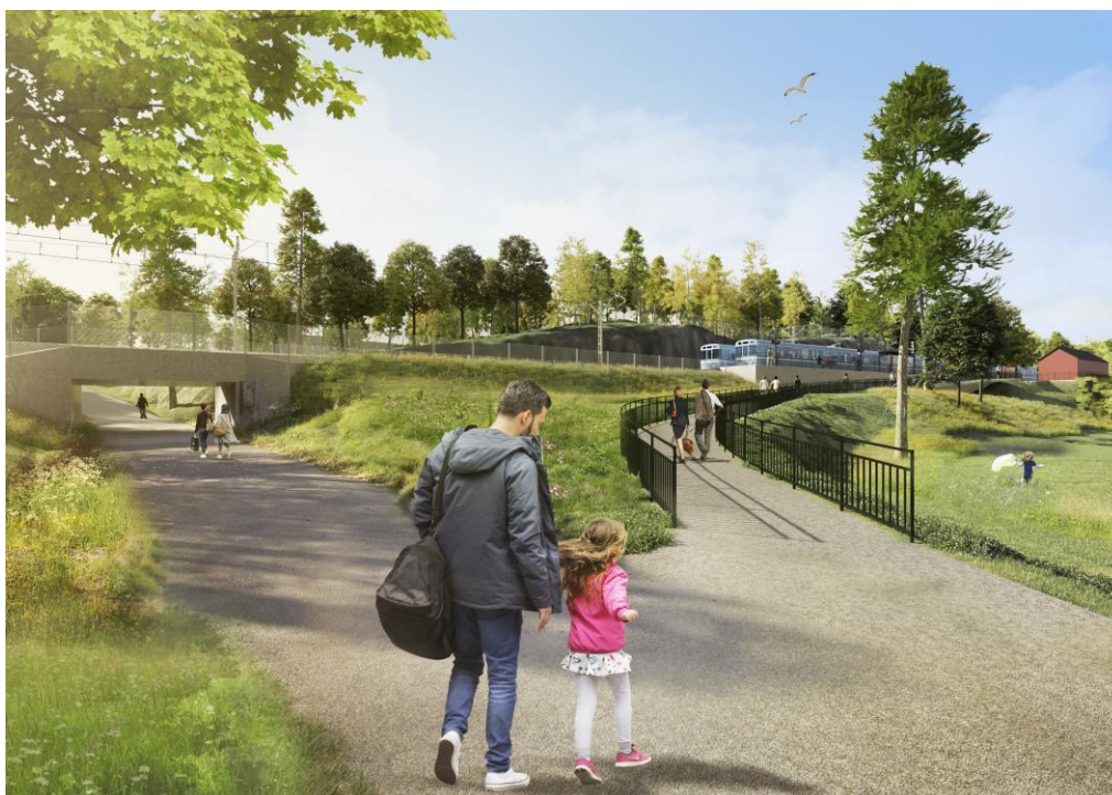
Figur 6. Gång- och cykeltunneln breddas, vy från norr. Ny ramp anläggs till norra plattformen. Sly och mindre träd röjs undan. Visualisering av Sweco Architects AB.
