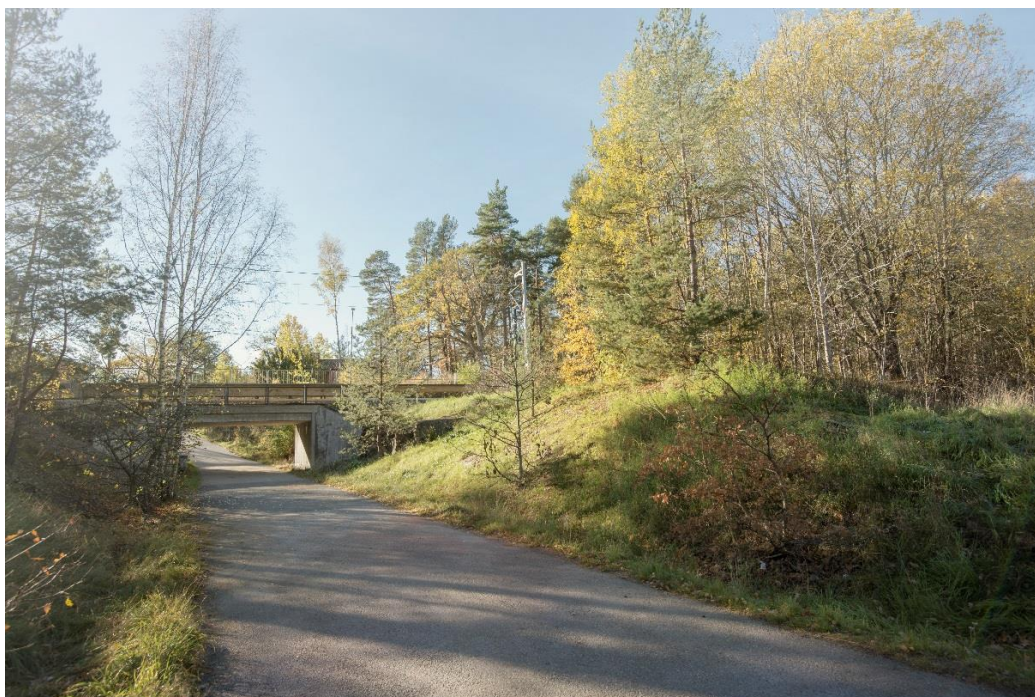
Figur 5. Dagens gång- och cykeltunneln som kopplar samman områden norr och söder om Saltsjöbanan, vy från norr. Foto av Sweco Architects AB.
