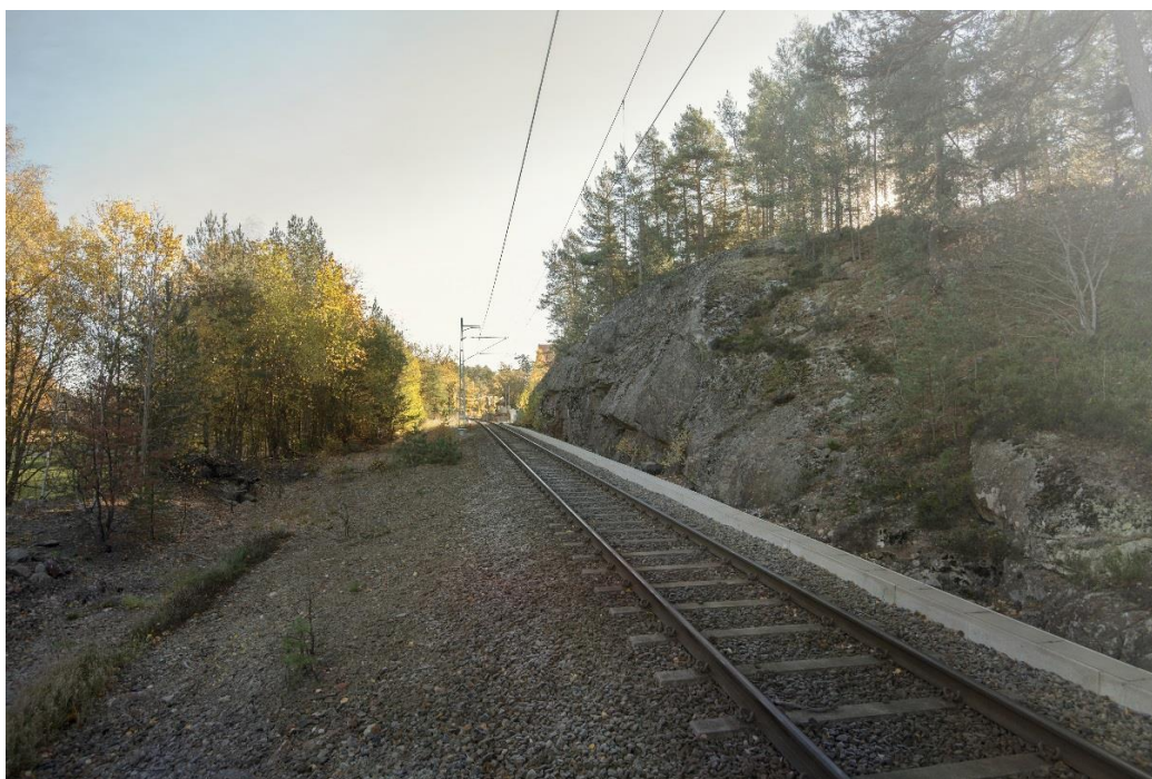
Figur 9. Dagens enkelspår, vy från väster. Till vänster ses befintlig slänt av krossmaterial. Till höger ses nuvarande bergskärning. Foto av Sweco Architects AB.
