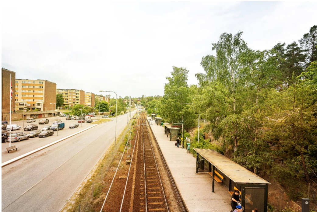
Figur 16. Dagens spårområde består av ett enkelspår med plattform på norra sidan, vy från gångbron i öster. Foto av Sweco.
