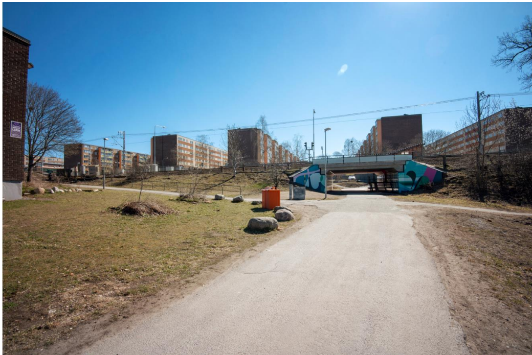
Figur 14. Gång- och cykeltunneln i planområdet västra del kopplar samman områdena norr och söder om Saltsjöbanan, vy från norr. Foto av Sweco.
