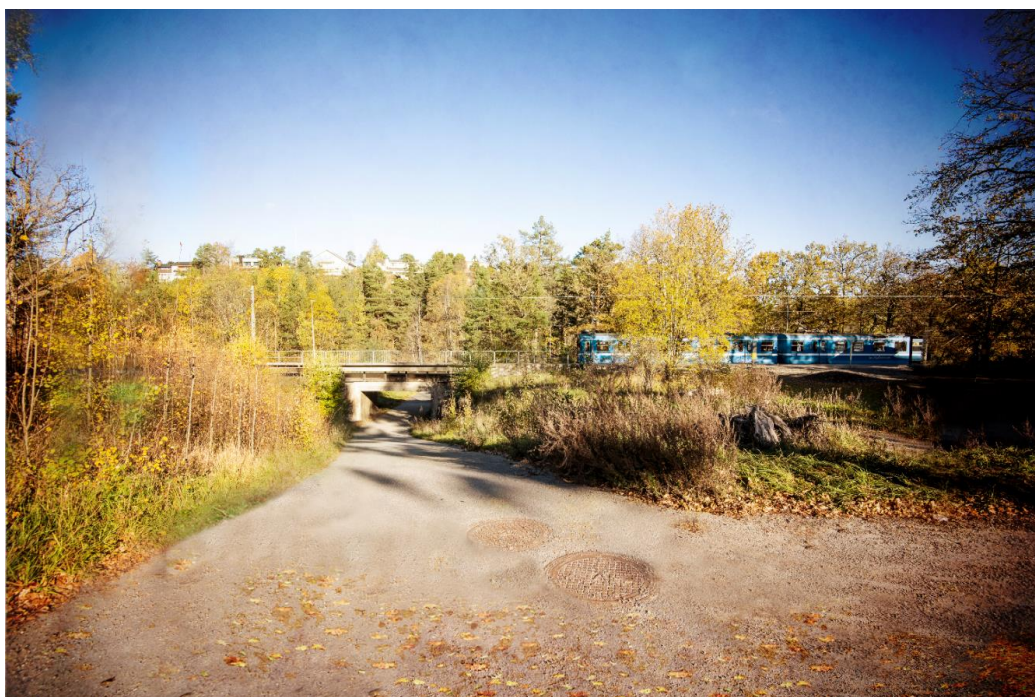
Figur 7. Dagens gång- och cykelväg och gång- och cykeltunnel, vy från söder. Foto av Sweco.
