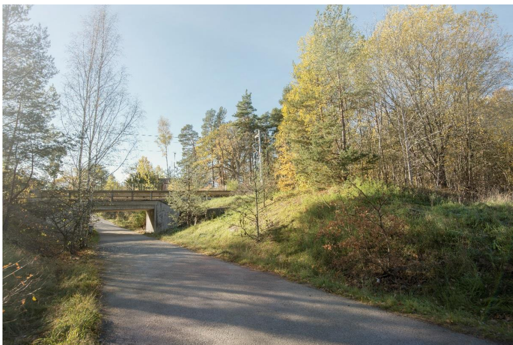
Figur 5. Dagens gång- och cykeltunneln som kopplar samman områden norr och söder om Saltsjöbanan, vy från norr. Foto av Sweco.
