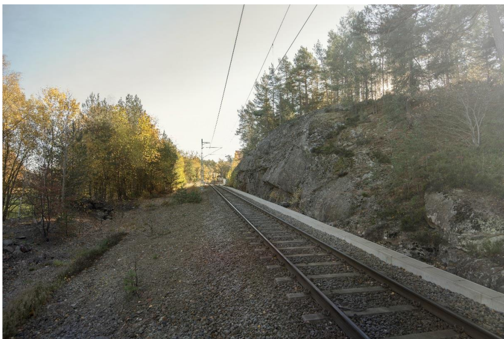
Figur 9. Dagens enkelspår, vy från väster. Till vänster ses befintlig slänt av krossmaterial. Till höger ses nuvarande bergskärning. Foto av Sweco.
