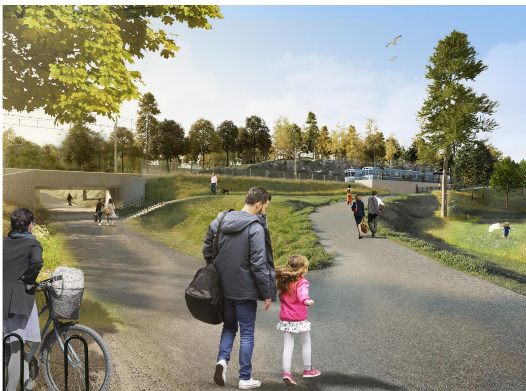
Figur 6. Gång- och cykeltunneln förlängs, vy från norr. Nya anslutningar genom gångvägar och trappa anläggs till norra plattformen. Sly och mindre träd röjs undan. Visualisering av Sweco.
