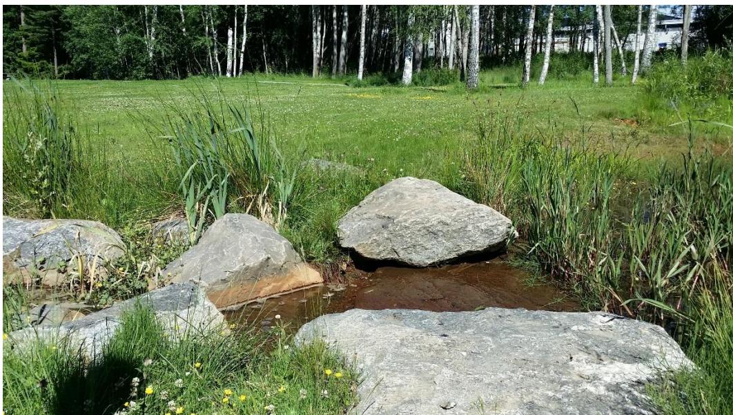
Figur 20. Hedvigslundsdammen, dämme över stenklack.
