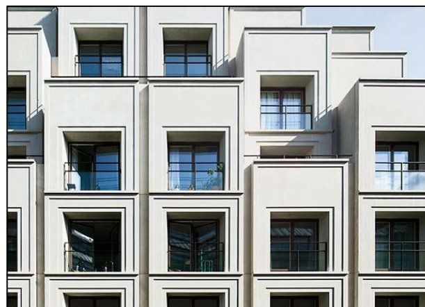
Referensbild som visar hantering av betongelement
