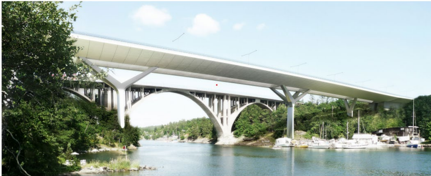
Den nya Skurubron byggs söder om den befintliga bron
