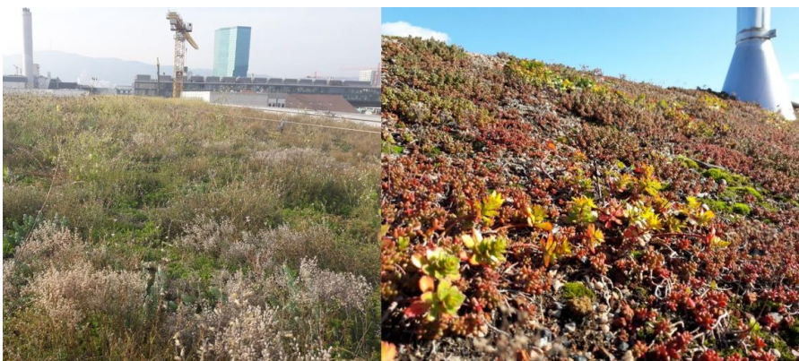
Figur 10. Exempel på tjockt grönt tak (intensivt) till vänster och tunt grönt tak (extensivt) till höger. Foto Robert Jönsson, WRS.
