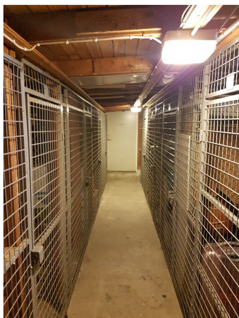
Vindarna består till mindre del av lättbetongblock (runt trapphusen och i övrigt av en enkla stolp- och regelkonstruktioner i trä. De är oisolerade med omålade träpanel som underlag för takpapp och plåtpanel. Fönstren ger visst dagsljus. På två av vindarna finns numera avstängda piskaltaner, till största delen integrerade i volymerna men avläsbara från gården.
