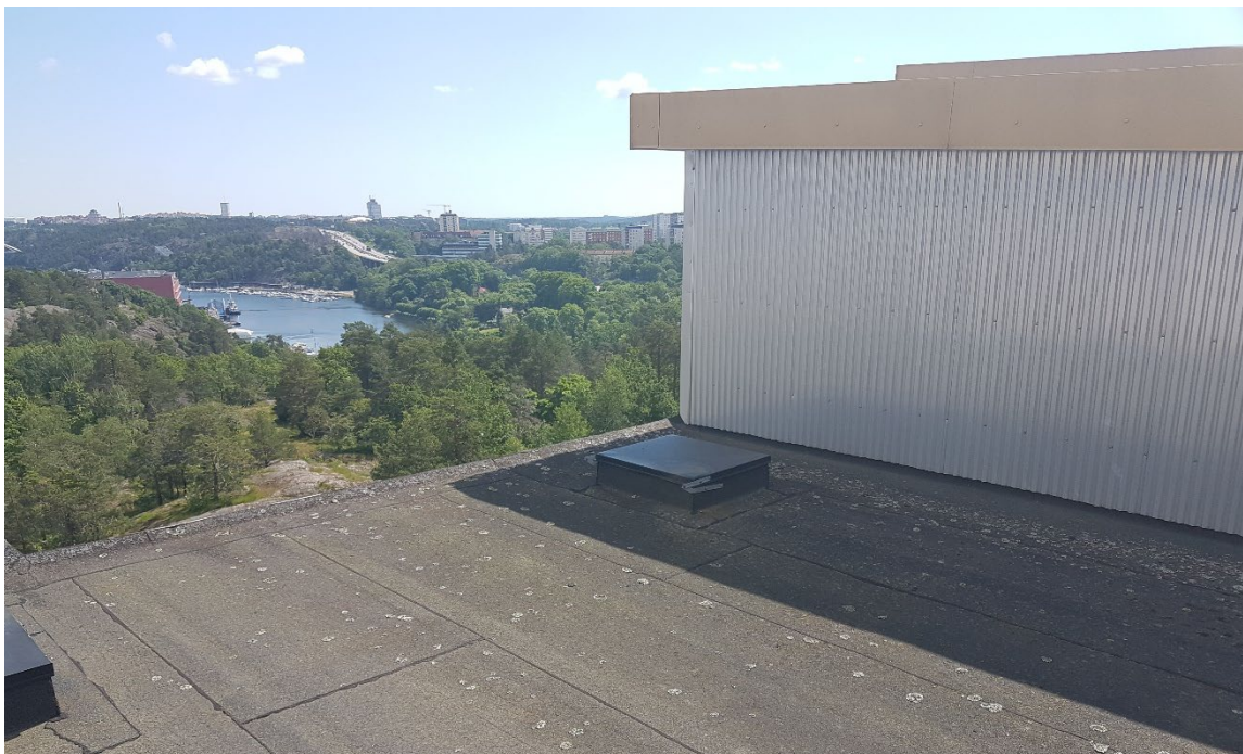
Mot utsidan är vindarna, i nära enlighet med skisserna, placerade närmast i liv med fasaden. Uppbyggnaderna är högre åt detta håll, takfallen (flacka pulpettak) lutar in mot gården. Uppbyggnaden på bilden har delvis utbytt fasadplåt. Färgen på takfotsinklädningen har här bättrats med roller.
