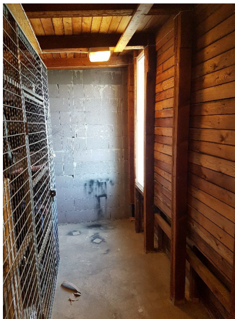
Vindarna består till mindre del av lättbetongblock (runt trapphusen och i övrigt av en enkla stolp- och regelkonstruktioner i trä. De är oisolerade med omålade träpanel som underlag för takpapp och plåtpanel. Fönstren ger visst dagsljus. På två av vindarna finns numera avstängda piskaltaner, till största delen integrerade i volymerna men avläsbara från gården.
