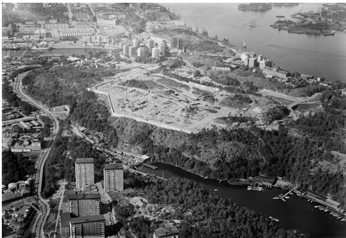
1967 hade anläggnings- och byggnadsarbetena påbörjats. Foto Erik Claesson, Riksantikvarieämbetet.
