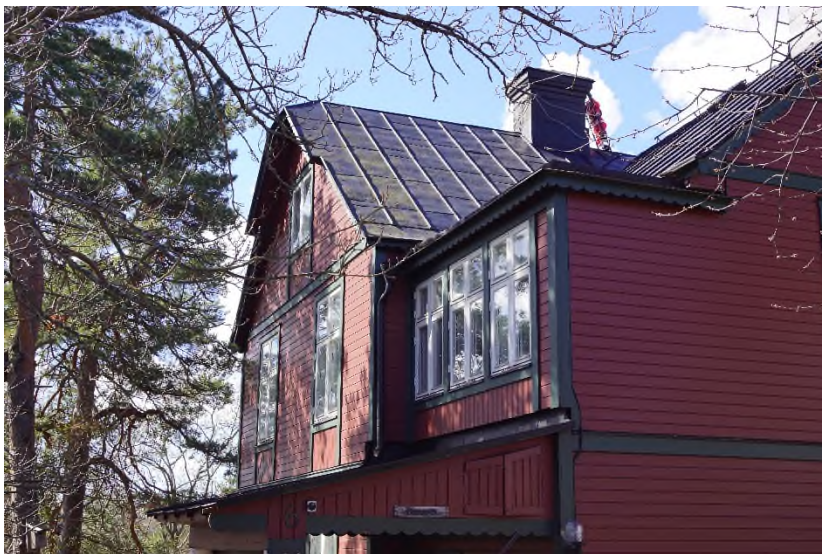
Detalj av taket.
