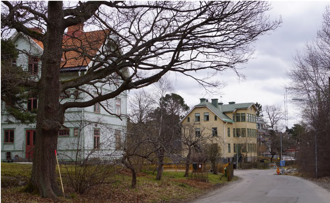
Birkavägen söderut med de två karaktäristiska hyresvillorna, Villa Samsjö till vänster och Villa Birka rakt fram i bild.
