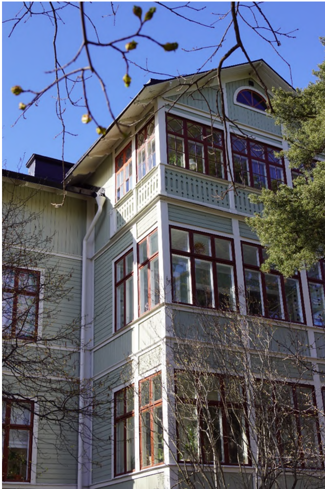
Sicklaön 132:16, Villa Britteberg, del av fasaden mot Kyrkstigen.
