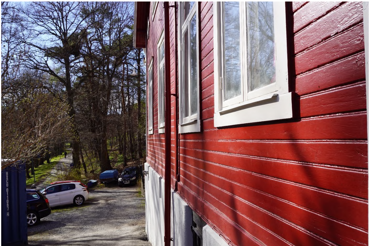
Detalj av fasaden med liggande pärlspontspanel.
