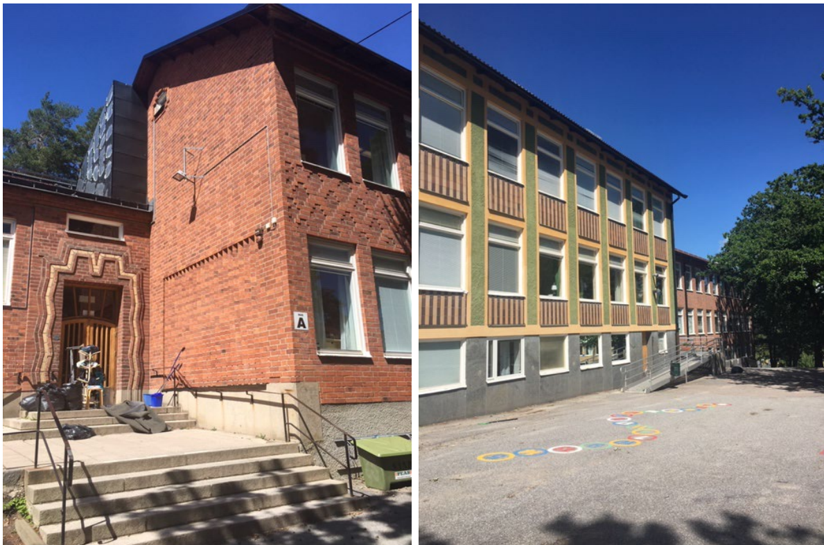
Figur 15. Foto över hus A till vänster och hus B till höger.
