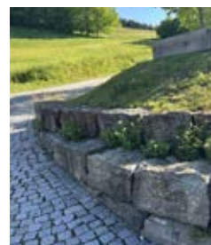
Återbrukande av befintliga murar till skyfallsparken
