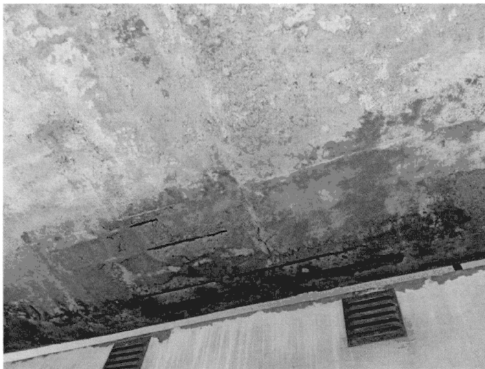
Exempel på ytskador undersida
