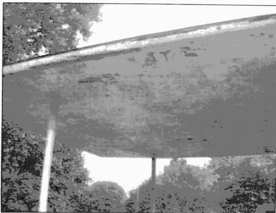
BILD 3. Skärmtaket med blottlagd armering och spjälkningar.
