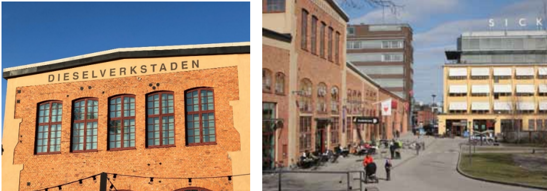
Foton som visar Dieselverkstaden - en äldre industribistorisk byggnad i Sickla.
