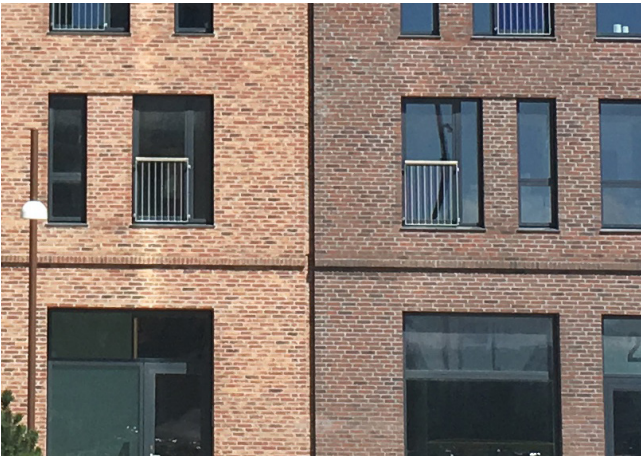
Skarvar mellan fasadelement som del av medveten gestaltning.
